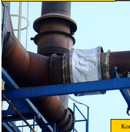
Potrubí kuploven ŽDB po rekonstrukci
