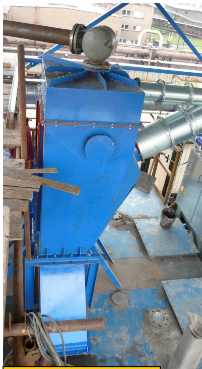
Montáž odprašovací jednotky
