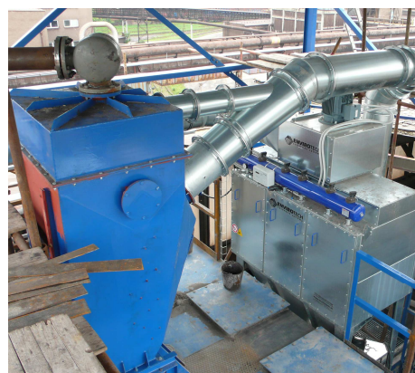
Montáž odprašovací jednotky
